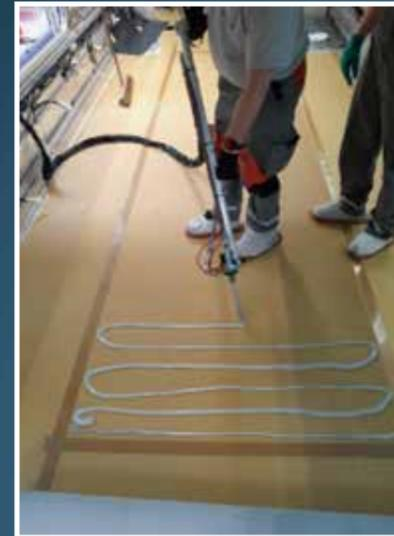
Abb. 7: Klebstoff wird mit der Maschine verteilt
