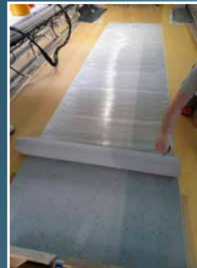
Abb. 9: Der Fußbodenbelag wird vorsichtig aufgelegt und abgerollt
