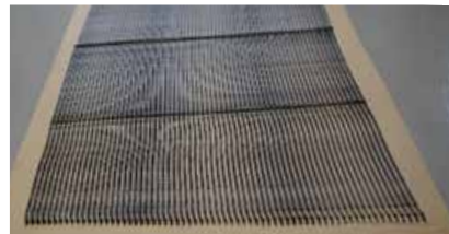
Abb. 2: Klebstoffauftrag mittels Klebekamm
