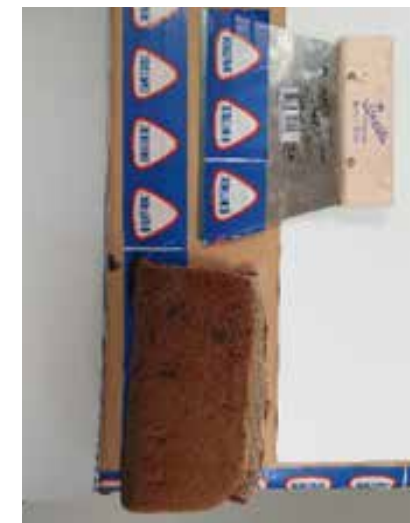
Abb. 5: Klebstoff mit Zahnpachtel verteilt
